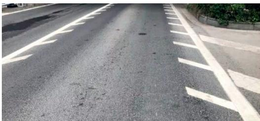
**答：**此标线是可变导向车道线，施划在交叉口进口导向车道上时，表示该车道的导向方向是可变的，而不是固定不变的。国家标准《道路交通标志和标线 第3部分：道路交通标线》（GB 5768.3—2009）4.8.4规定，可变导向车道线用于指示导向方向随需要可变的导向车道的位置。
