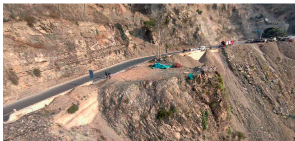
图1 某地省道事故路段临崖一侧无路侧护栏，发生车辆翻坠事故
