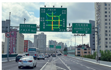
图5 可变信息标志在快速路中应用实例
