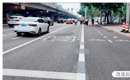
月坛北桥路口北进口设置非机动车前置待转区前后对比
